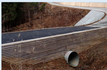
こがねざわ しらかわ 新設した黄金沢林道専用道 (左)令和7(2025)年12月 (右)令和8(2026)年1月)
