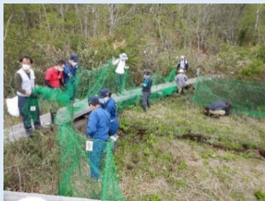
湿原を保全するための防護柵の設置 (群馬県沼田市：令和7(2025)年6月) (提供：沼田市役所 環境課)
