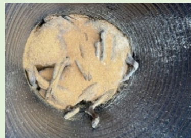
大型排水管内部の様子
