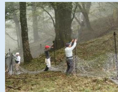
ボランティアによる防護柵設置 (高知県香美市：令和7(2025)年10月)
