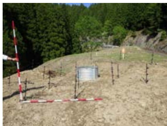
R5年度 コルゲート管(大型排水管)
