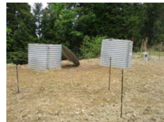
R6年度 コルゲート管(大型排水管)
