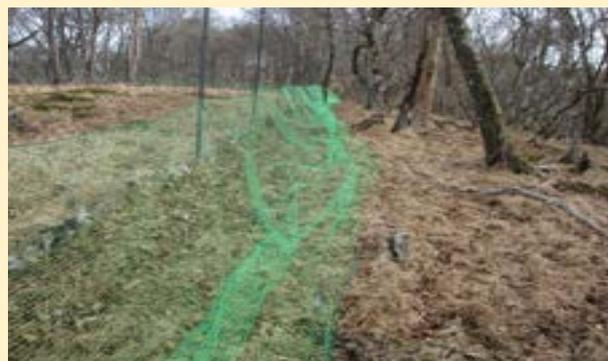
防護柵の最下部から約50cmの位置に低コスト資材のネット(1巻50m幅1.5m)を余裕を持たせ緩く重なるように斜めに設置した状況
