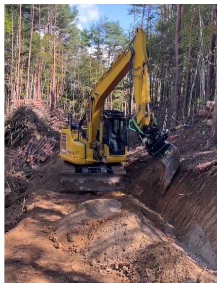
林道工事などの狭小な現場でも掘削・法面整形が可能
