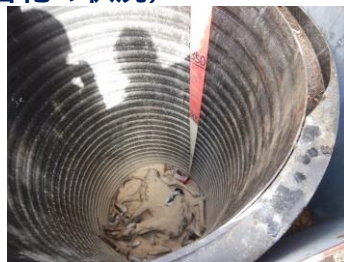
埋設完了時:かさ高2.0m (4.5頭投入)
