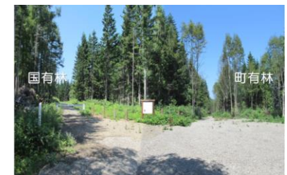
国有林と民有林を連結した林業専用道
