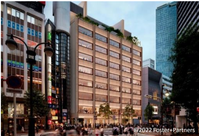
戸田建設、住友林業、シェルターが連携し施工中の 「渋谷マルイ」
