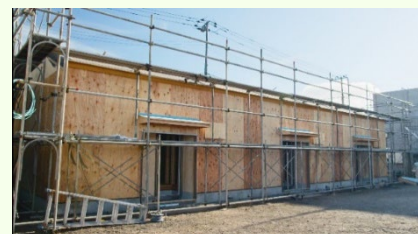
【アクトが自社開発したパネル構法施工例】
