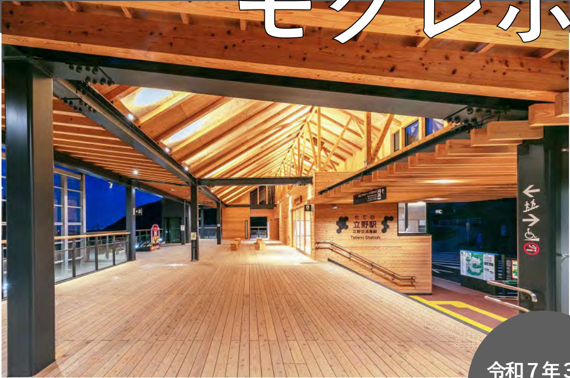
○立野交流施設（立野駅）（熊本県阿蘇郡南阿蘇村） ※令和6年度木材利用推進コンクール（優良施設部門）農林水産大臣賞
