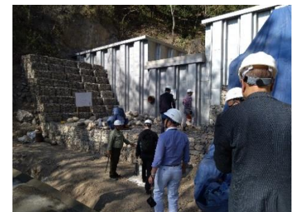
JICA山地災害対策プロジェクト施工箇所
