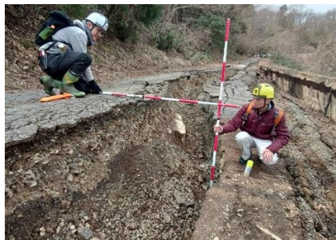
路体が決壊した林道を調査する様子 （輪島市 林道佐比野線）※写真は石川県提供
