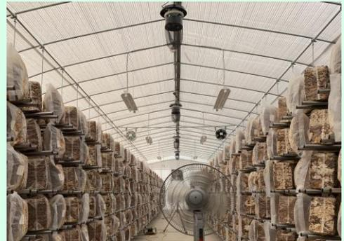
・きのこ栽培における断熱性能の高い被覆資材等の利用による燃油使用量の削減
