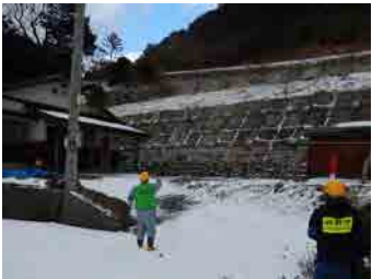
避難所での点検状況
