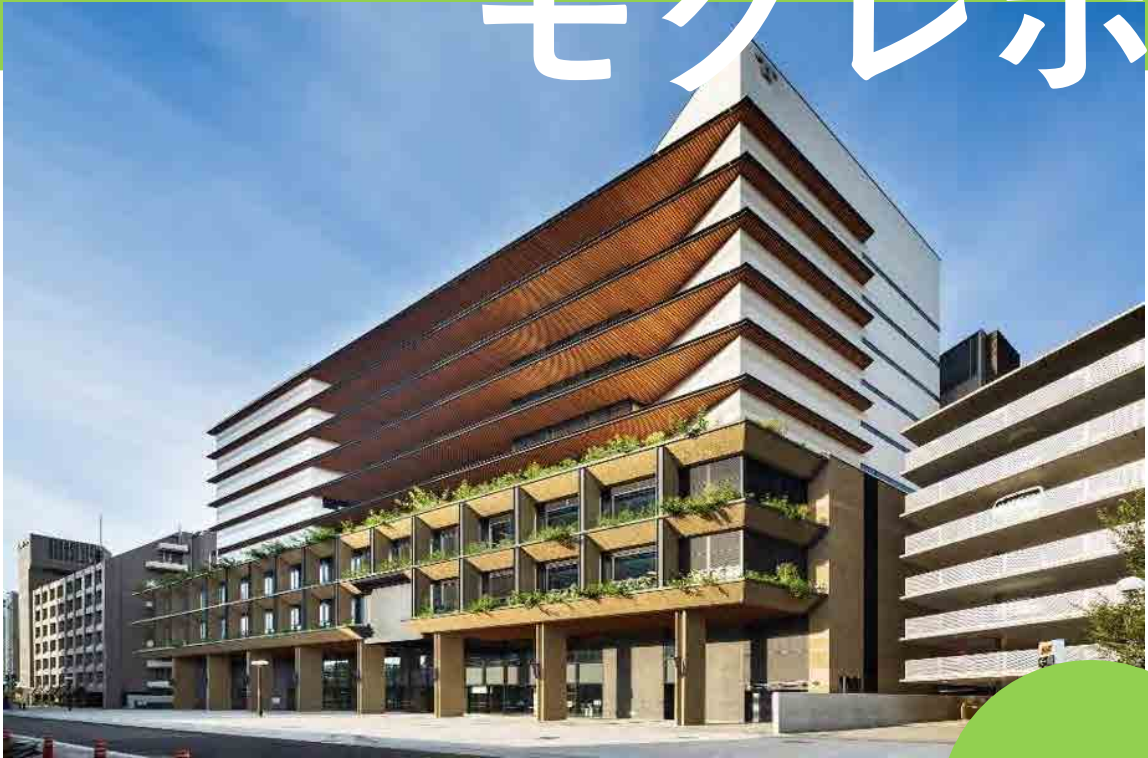
○神戸市中央区役所・中央区文化センター（兵庫県神戸市） ※令和5年度木材利用優良施設等コンクール 林野庁長官賞
