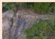
ドローンを活用した被災状況調査
