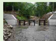
流木捕捉式治山ダム工
