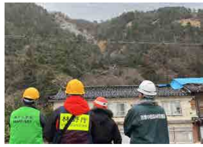
MAFF-SATによる現地調査(1/12・輪島市)
