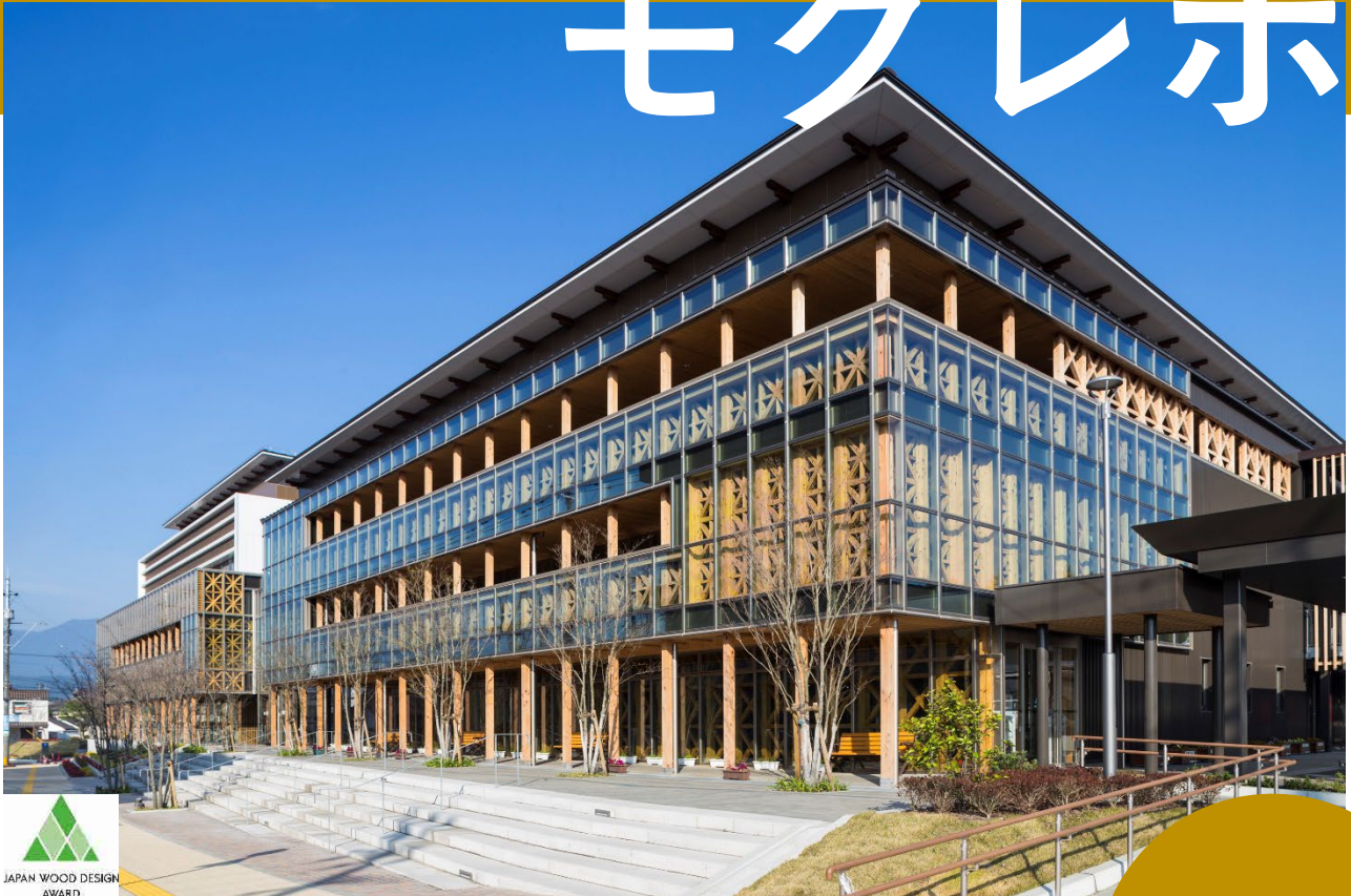
○宮崎県小林市新庁舎（東館）
