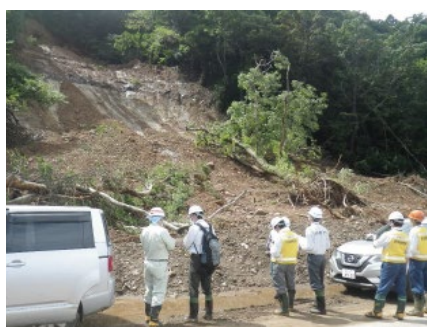
大規模山地災害発生時における専門家等との合同調査
