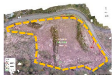
ドローンによる測量
