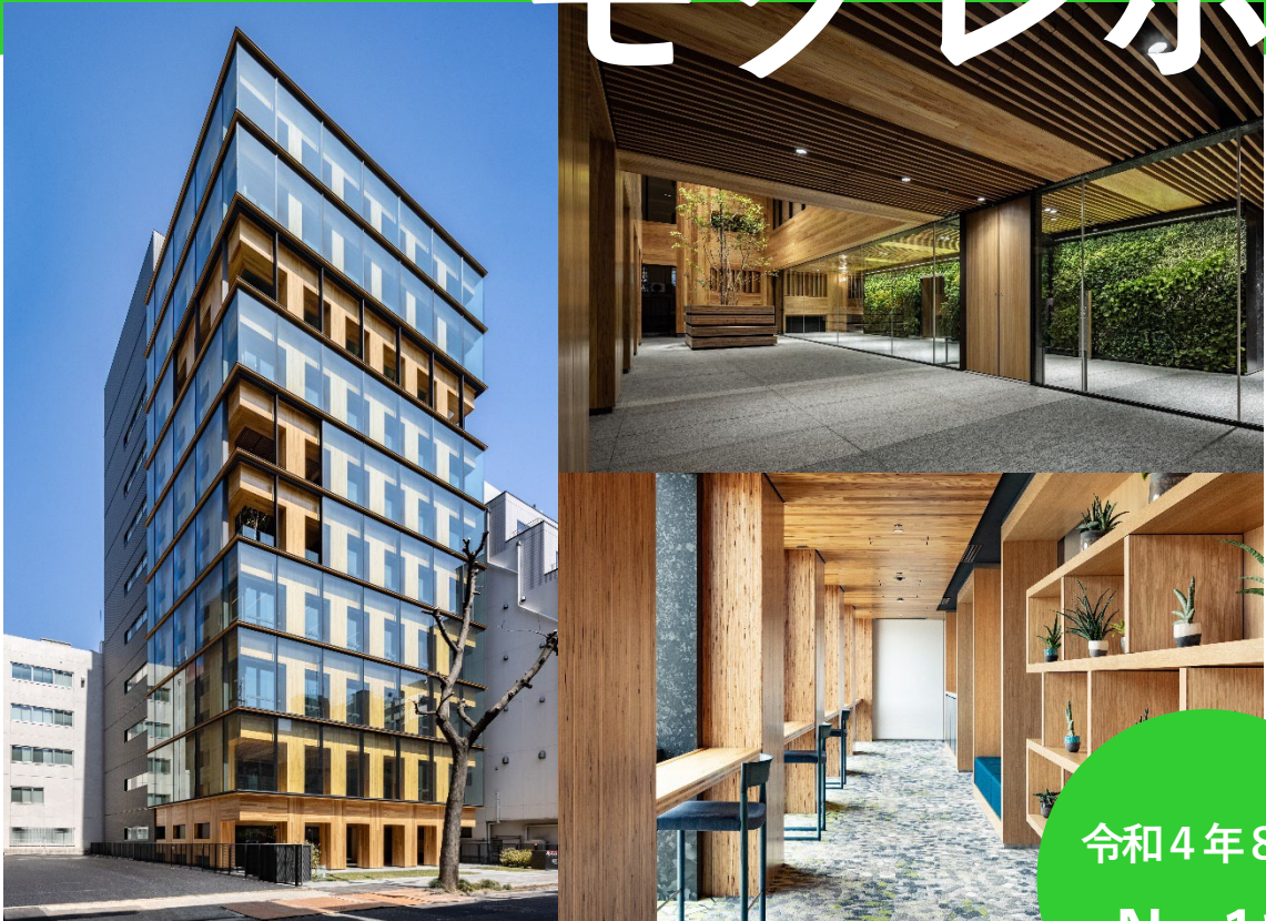
○木造11階建てビル「Port Plus」(横浜市中区)の外観(左側)と内装(右側) 設計・施工:株式会社大林組(2022年竣工)
