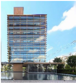
タクマビル新館(研修センター) (兵庫県)
