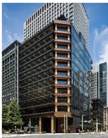
清水建設が設計・施工した木造ハイブリッド構造オフィスビル「第一生命京橋キノテラス」(2025年7月竣工) 及び木質建築技術「シミズ ハイウッド®」シリーズ
