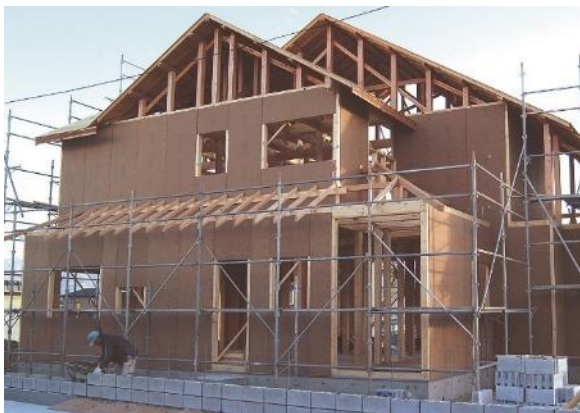
木質ボードを内装部材や構造用壁材などに利用した建築物
