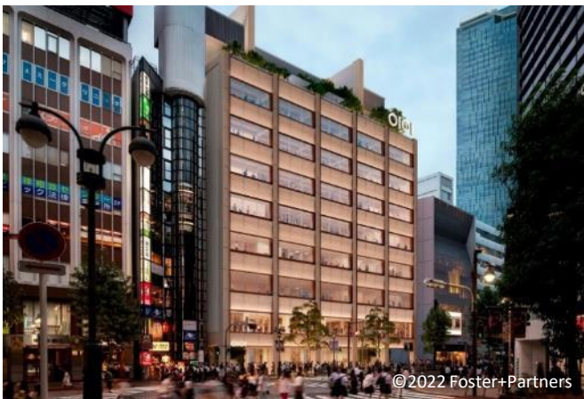
戸田建設、住友林業、シェルターが連携し施工中の 「渋谷マルイ」
