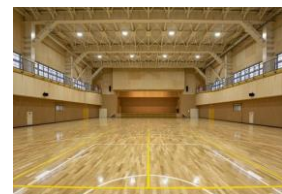
防衛省 陸上自衛隊俱知安駐屯地体育館 (北海道) [床、壁]
