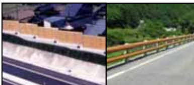
遮音壁、木製ガードレール 等
