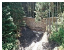
地域材を活用した治山ダム
