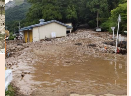
下流への 土砂流出
