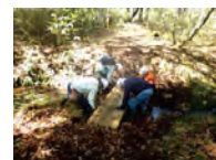
歩道整備の様子 （長野県長野市（戸隠・大峰自然休養林））
