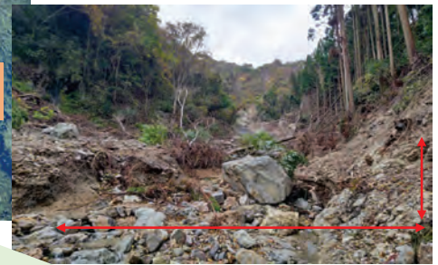
土石流により溪流の縦方向、横方向ともに激しく浸食
