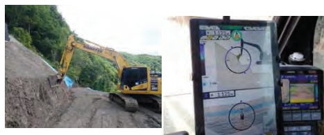
治山事業におけるICT活用事例 （MG（マシンガイダンス）付きバックホーによる掘削）
