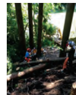
作業道の敷設
