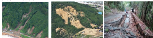
令和3年台風第9号（青森県風間浦村） 石川県能登半島における災害（左：地震、大雨による崩壊斜面からの土砂流出（珠洲市）右：地震による林道災害（輪島市））
