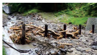
長野県下伊那郡天龍村 令和5年梅雨前線豪雨において、 流木止工が流木等を捕捉
