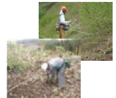
造林作業の様子
