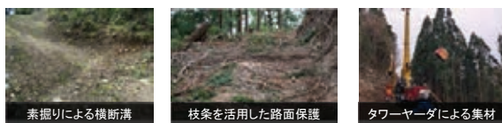
索掘りによる横断溝
