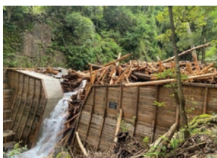
流木捕捉式治山ダムが流木及び土石を捕捉した事例【熊本県球磨村】
