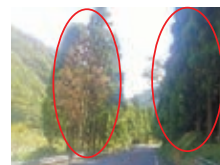
国道沿いの危険木除去予定箇所
