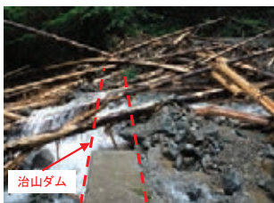
治山ダムが渓流の勾配を緩やかにしてため流木流出を抑制した事例【福岡県八女市】
