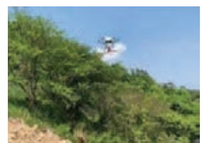
ドローンによる崩壊地の緑化
