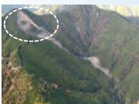
大規模・急傾斜地での崩壊発生
