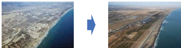
民有林直轄治山事業等による復旧・再生(宮城県仙台市ほか)
