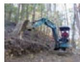
作業道作設風景
