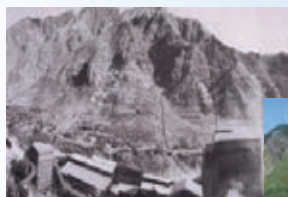
荒廃状況(昭和45年)
