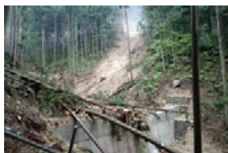
治山ダムが崩壊地から流れ出た土砂や倒木の流出を抑制した事例【岐阜県下呂市】
