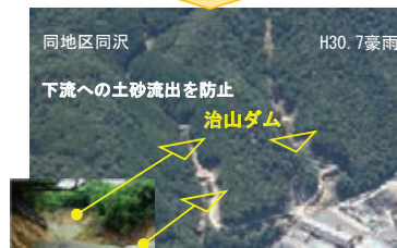
治山ダムが土砂流出を抑制し、下流への被害を防止。
