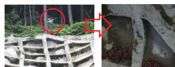
ドローンを活用した、施設の点検
