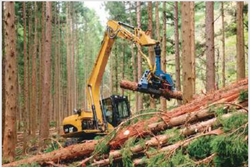
ふくしま森林再生事業による間伐作業(福島県)
