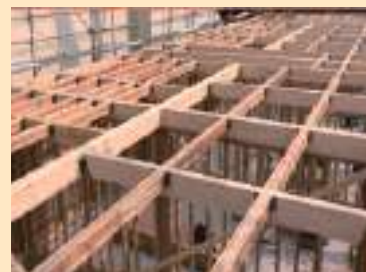
スギ枠組壁工法製材の床根太(床板を支える横架材)への活用
