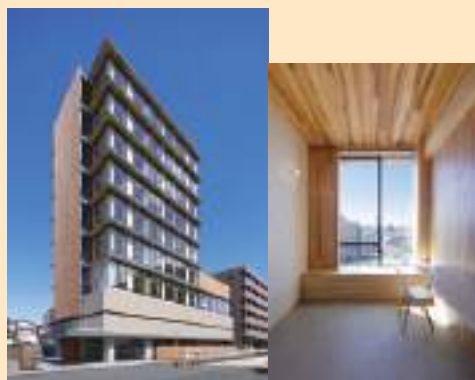
奥村組西川口寮 (埼玉県川口市、令和7(2025)年2月竣工) 柱・梁に埼玉県飯能市の西川材を使った木質耐火部材を、耐震壁にCLTを採用し、3階以上を木造(一部鉄筋コンクリート造)とした8階建ての社員寮 (撮影：志摩大輔氏)
