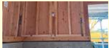
住宅用の建築金物のみで補強
