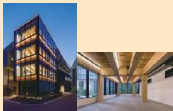
TQ渋谷宇田川町 (東京都渋谷区、令和7(2025)年4月竣工) 水平力を鉄筋コンクリート部分に負担させ、木造部分に耐力壁を設けない2方向ラーメン架構とし、木造躯体を外観から見せるデザインを実現した木造と鉄筋コンクリート造のハイブリッド構造の4階建て事務所兼店舗ビル
