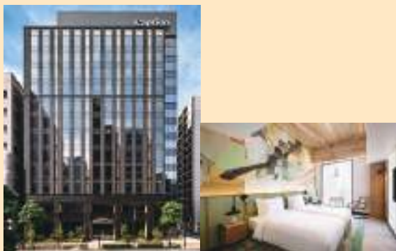
キャプション by Hyatt 兜町 東京 (東京都中央区、令和7(2025)年6月竣工) 地下1階を鉄筋コンクリート造、1～2階を鉄骨造、3階以上を木造と鉄骨造のハイブリッド構造とし、外周部に木柱・木梁を使用することで、外部から木材が認識できるデザインとした地上12階建て・地下1階建てのホテル
