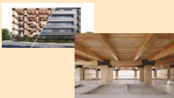
伊藤忠商事寄宿舎棟 (神奈川県川崎市、令和7(2025)年3月竣工) 1方向ラーメン構造と耐力壁構造を組み合わせた構法を採用し、柱、梁、耐力壁等の構造フレームの大部分を木造化した1.5時間耐火構造の5階建て社員寮 (写真提供：井上隆司氏(右下))
