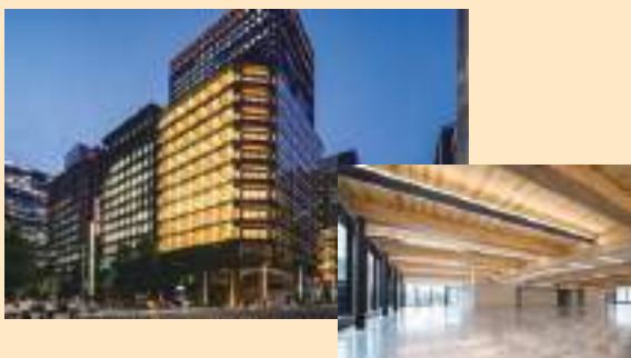
第一生命京橋キノテラス (東京都中央区、令和7(2025)年7月竣工) 木造と鉄骨造のハイブリッド構造で、40m×17mの木質無柱空間を実現しており、木材使用量は約1,100m 3 に上る地上12階・地下2階建てのオフィスビル (写真提供：清水建設株式会社)
