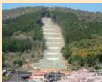
施工直後(令和3(2021)年3月)
