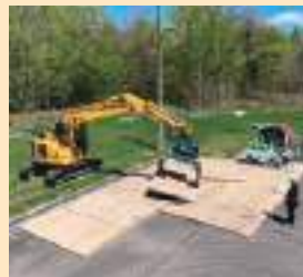
CLTの敷板 鉄製に比べて、軽量で輸送や敷設が容易、熱伝導率が低く猛暑期の敷板上の温度が上がりにくいなどが利点
