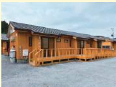
木造応急仮設住宅の外観
