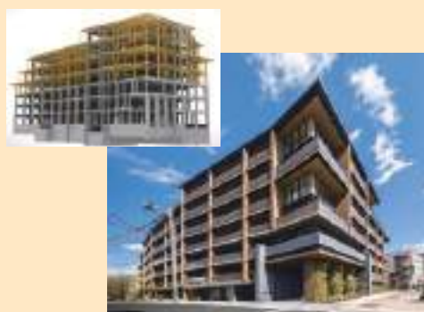
ブランシエスタ目黒中央町 (東京都目黒区、令和7(2025)年3月竣工) 1～3階を鉄筋コンクリート造、4階以上を木造とのハイブリッド構造とし、木造住戸(101戸のうち36戸)の全ての壁を非耐力壁としたことで、間取りの自由度等を向上させた7階建て賃貸マンション
