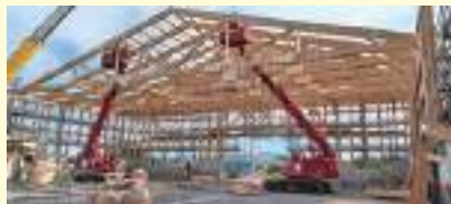
建設中の様子
