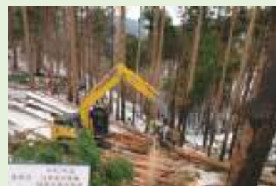
焼損した被災木の伐採 (令和8(2026)年1月)
