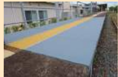
CLTのプラットフォーム コンクリート等では必要な養生期間が不要なため施工期間を短縮できる、軽量で設置が容易であることなどが利点
