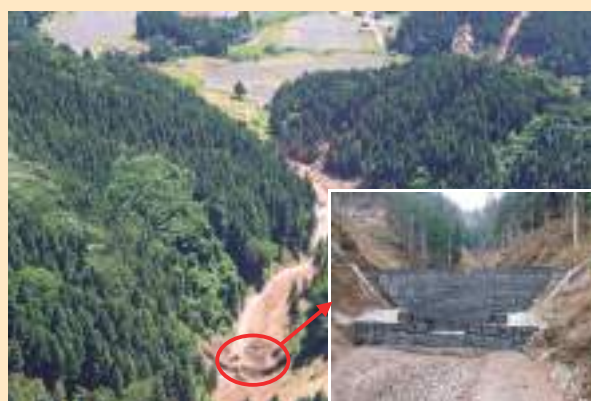
被害箇所の様子と 設置された治山ダム(令和7(2025)年11月) (輪島市興徳寺区域)
