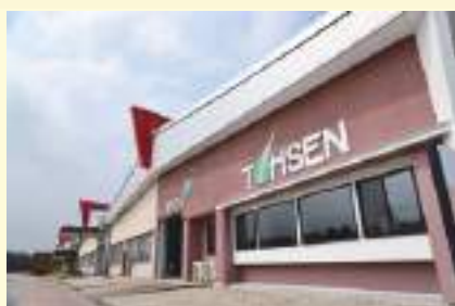
デカレ矢板の製材工場
