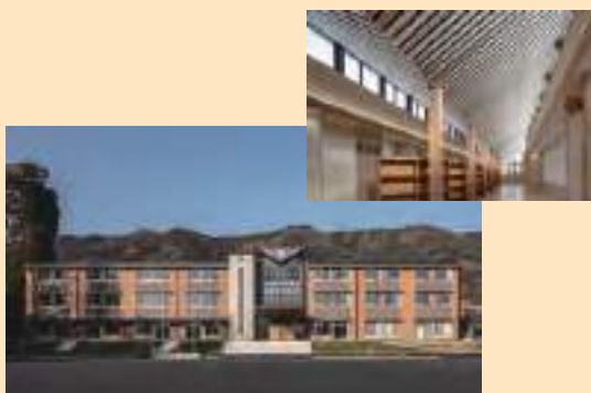
松田町立松田小学校 (神奈川県松田町、令和5(2023)年2月竣工) 1時間準耐火構造を有し、中央のRCコア棟の両側に木造校舎を配置することで延焼防止を実現した、国内3例目(設計時)の木造3階建て学校 (写真提供：浅川敏氏)
