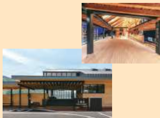
立野交流施設(立野駅) (熊本県南阿蘇村、令和5(2023)年4月竣工) 製材の登り梁による大屋根を鉄骨構造の上に載せることで、県産の大径材と地域の施工技術の活用を可能とした、熊本地震により被災した駅舎を再建した2階建て駅舎兼交流施設
