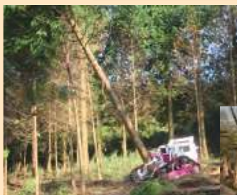
遠隔操作伐倒機械による伐倒の様子
