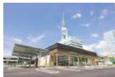
セブン-イレブン福岡ももち店 (福岡県福岡市、令和6(2024)年竣工)
