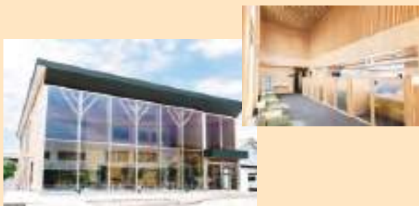
津山信用金庫二宮支店 (岡山県津山市、令和6(2024)年4月竣工) 建築物木材利用促進協定の下、使用する木材を全て岡山県産ヒノキとし、大断面集成材を通し柱や梁に使用した木造店舗
