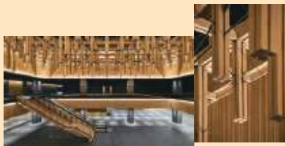
Toyota Technical Center Shimoyama 車両開発棟・来客棟 (愛知県豊田市、令和5(2023)年11月竣工) 豊田市内の人工林の間伐材を積極的に使い、吹抜空間の架構として成立させるなど、地元の将来の森づくりへの貢献を目指した建築物
