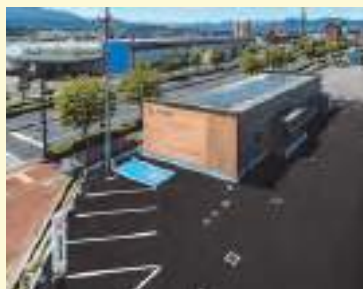
新築された営業拠点の外観
