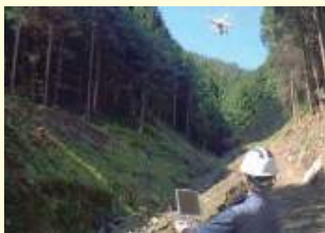
ドローンによる起工測量状況
