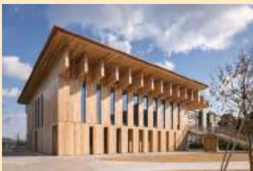
岡山大学共育共創コモンズ(OUX:オークス) (岡山県岡山市、令和5(2023)年1月竣工) CLTを壁や梁等に活用し、スパン18mの大空間や各階での自由な壁パネル配置を実現 (写真提供：佐藤和成氏)
