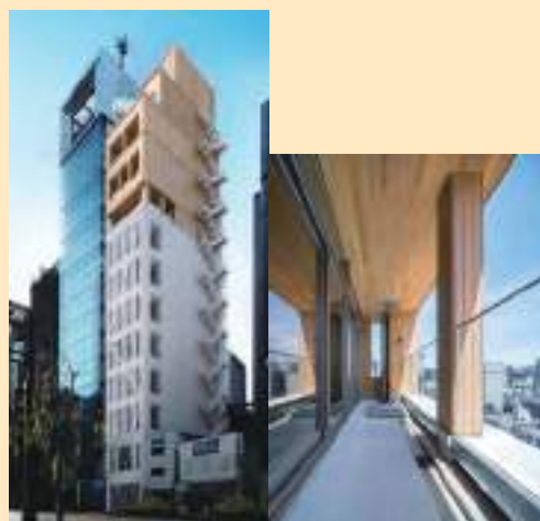
銀座高木ビル (東京都中央区、令和5(2023)年5月竣工) 東京都多摩地域のスギを利用して9階以上を木造とした12階建て複合商業ビル (写真提供：株式会社シェルター)
