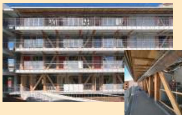
徳島県新浜町団地県営住宅2号棟 (徳島県徳島市、令和5(2023)年2月竣工) 大断面集成材の柱・梁による軸組構造で、構造材を現しで用いた木造4階建て準耐火構造で全国初となる県営住宅
