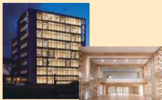
AQ Group新本社ビル (埼玉県さいたま市、令和6(2024)年3月竣工) 一般に流通する木材・金物と住宅用プレカット加工技術を用いた普及型の8階建て純木造ビル
