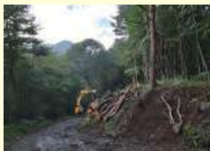
自然林への転換作業
