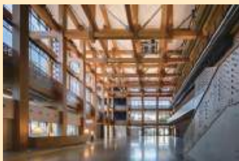
水戸市民会館 (茨城県水戸市、令和4(2022)年10月竣工) カラマツの耐火集成材によるやぐら組とトラス架構で大スパンを実現した4階建て耐火建築物 (写真提供：株式会社竹中工務店)
