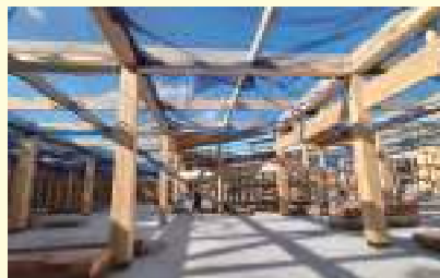
木造店舗の建設の様子
