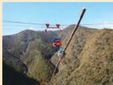
集材作業の遠隔操作が可能な架線式グラップルと油圧式集材機
