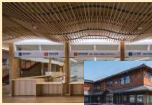
小鹿野町役場 (埼玉県小鹿野町、令和5(2023)年2月竣工) 流通規格材を組み合わせた組立柱を取り入れるなど、地域材を最大限に活用した純木造庁舎 (写真提供：小川重雄氏)
