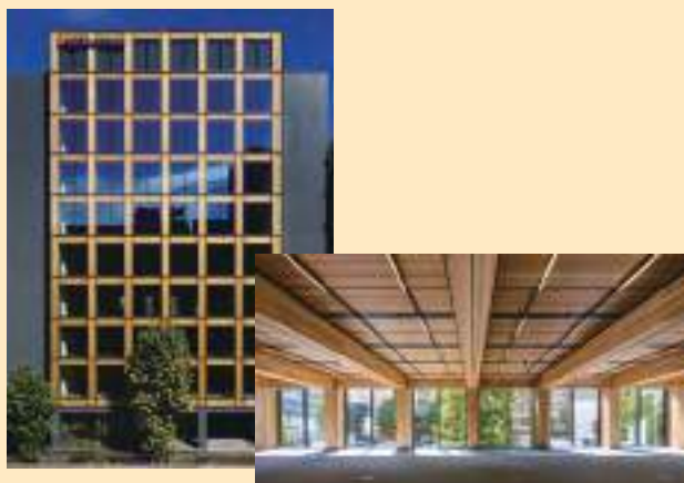
野村不動産溜池山王ビル (東京都港区、令和5(2023)年10月竣工) 木質構造部材と鉄骨造を合理的に組み合わせ、21m×18mの開放的な無柱空間を実現した9階建てオフィスビル
