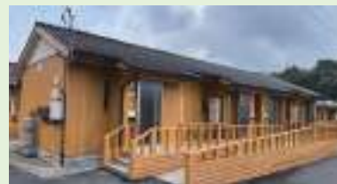
木造応急仮設住宅(長屋型)
