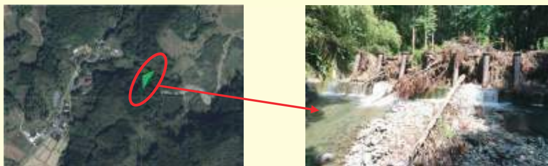
治山ダムによる流木の捕捉状況(熊本県高森町)
