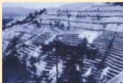
山腹工の施工(大正6(1917)年)
