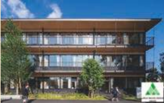
流山市立おおぐろの森中学校 (千葉県流山市、令和4(2022)年3月竣工) LVL、CLT、製材等を組み合わせて鉄筋コンクリート 造と同等のコストで実現した木造校舎 (写真提供：株式会社川澄・小林研二写真事務所)
