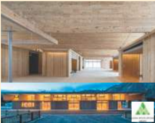
みなみあいづ森と木の情報・活動ステーション 「きとね」 (福島県南会津町、令和4(2022)年3月竣工) 地元産製材の重ね梁や縦ログによる木造2階建て (写真提供：南会津町)
