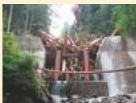
流木捕捉式治山ダムの 整備
