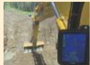
ICTバックホウによる施工
