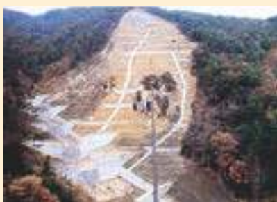
施工中(昭和55(1980)年)
