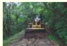
8月18日 林道の補修
