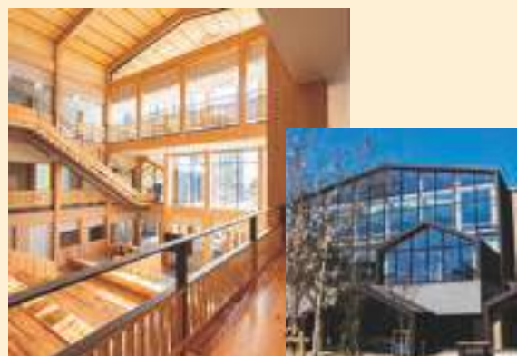
学校法人立命館 立命館アジア太平洋大学 教学棟「グリーンcommons」 (大分県別府市、令和5(2023)年3月竣工) 大分県産材による木造と鉄骨造を組み合わせた 3階建て校舎 (写真提供：学校法人立命館)
