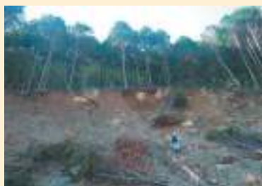
「令和2年7月豪雨」での崩壊 (崩壊深：約5m) (熊本県津奈木町)
