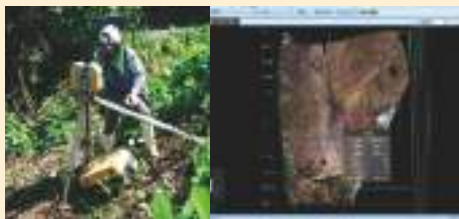
3Dレーザスキャナによる測量
