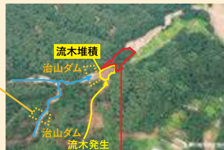
造林地が緩衝林として機能し流木の流出を抑制
