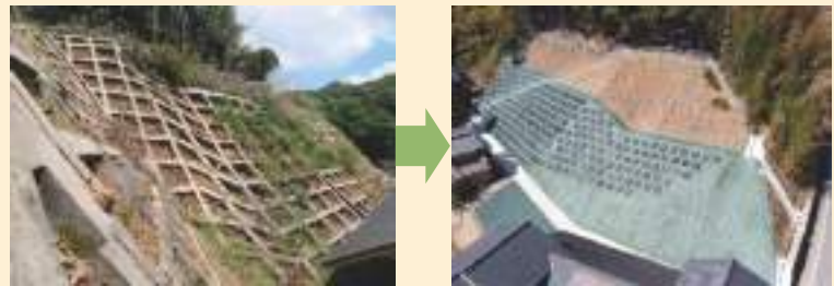
老朽化した施設を更新し、山腹斜面の安定度を向上(広島県尾道市)
