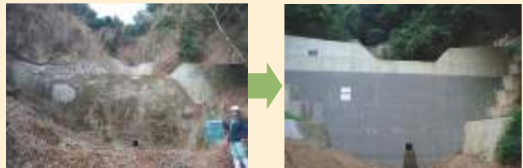
既存ダムをかさ上げ・増厚することにより機能強化・長寿命化(兵庫県神戸市)
