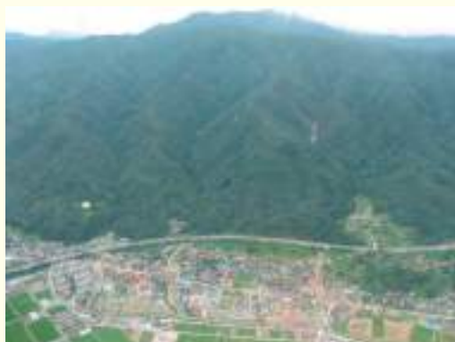
土砂流出防備保安林の全景
