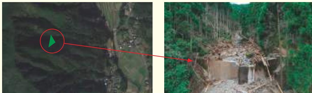
治山ダムによる土砂等の流出抑制効果(鹿児島県さつま町)
