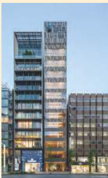
12階建て商業施設 HULIC & New GINZA 8 (東京都中央区、令和3(2021)年竣工)
