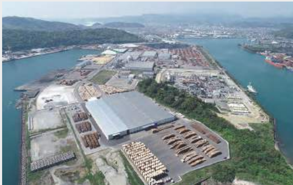
大規模製材工場(宮崎県日向市)
