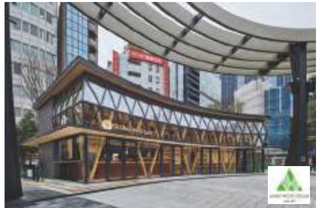
内装などに木材が多用された都心駅前の シンボリックな複合施設 池袋西口公園 GLOBAL RING CAFE (東京都豊島区、令和元(2019)年竣工) (写真提供：(株)三菱地所設計)
