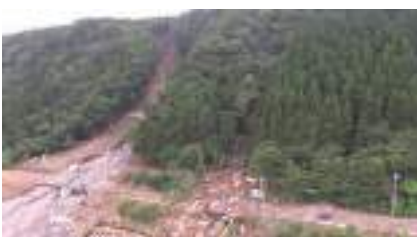
土砂等の流出による国道の寸断 (青森県風間浦村)
