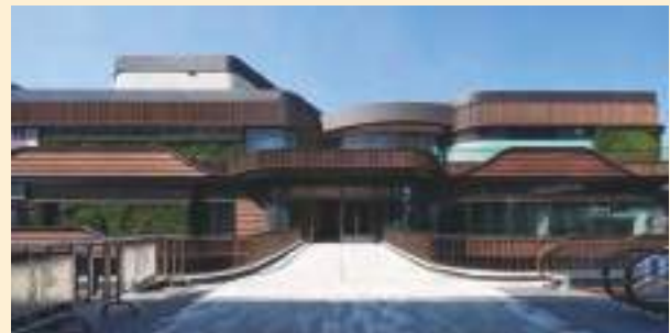
上海のショッピングモールの外壁飾り(スギ・ヒノキ) (写真提供:越井木材工業株式会社)
