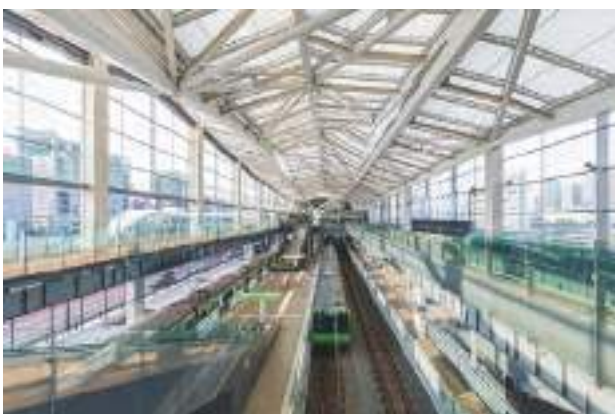
大屋根の梁や柱に木材を多用した新駅舎 高輪ゲートウェイ駅 (東京都港区、令和2(2020)年竣工)
