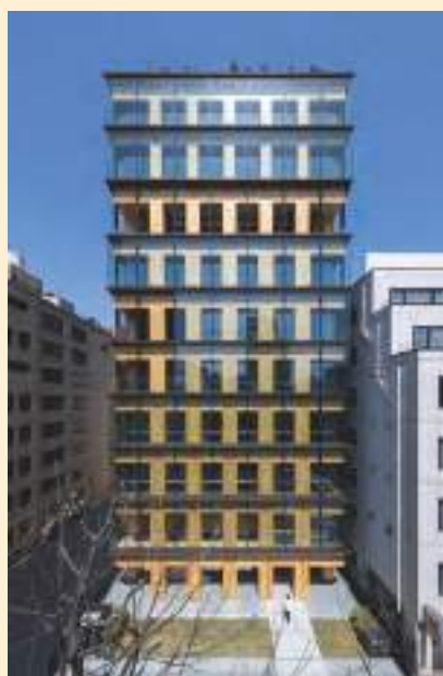
11階建て研修施設 Port Plus (神奈川県横浜市、令和4(2022)年竣工)
