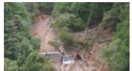
治山施設による土砂や流木の流出抑制 (青森県風間浦村)
