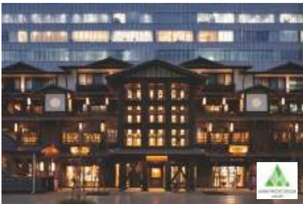
4階建て2時間耐火の木造商業施設 ミナカ小田原 (神奈川県小田原市、令和2(2020)年竣工)
