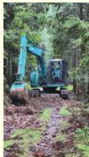
代替路整備の様子
