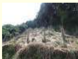
<保護柵設置後>
