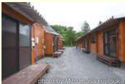
photo by Mitsumasa Fujitsuka ログハウス仮設住宅(2011年)
