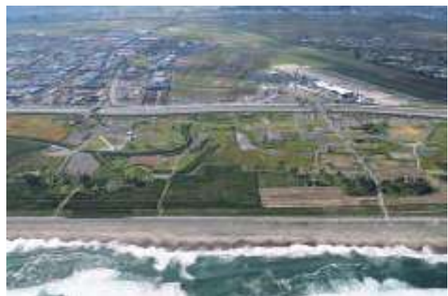
海岸防災林の植栽完了後 (令和2(2020)年10月撮影)
