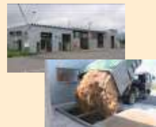
木質チップボイラーへの搬入
