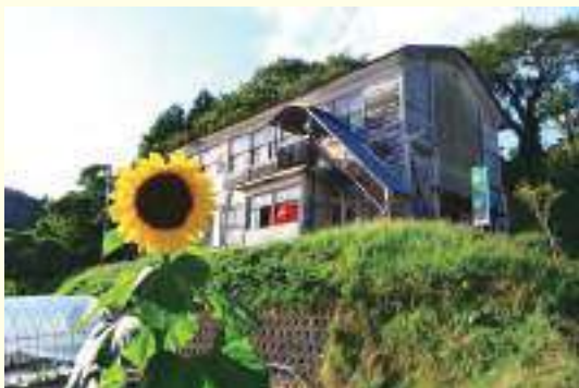
木造校舎をリノベーションした工房
