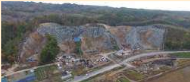
平成30年胆振東部地震の災害復旧状況(北海道)
