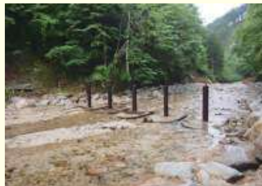
施工地全景(中部森林管理局 ちゅうぶしん 東濃森林管理署 (平成30(2018)年施工))
