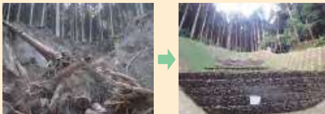
平成30年7月豪雨の災害復旧状況(愛媛県)
