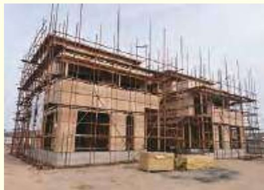
建設中の木造軸組住宅(中国・大連)
