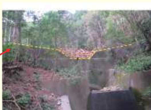
治山ダム(昭和62(1987)年度施工)による流木の流出等の抑制効果(三重県紀北町)
