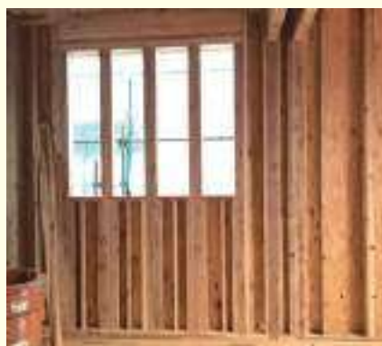
施工事例（市川ホームギャラリー）
