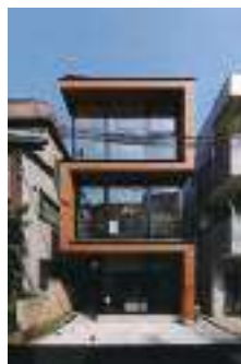
allée de JINGUMAE (東京都渋谷区) (令和元年度木材利用優良施設 コンクール受賞施設)
