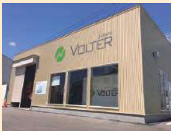
道の駅「たかのす」の発電所(40kW)
