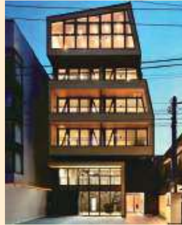
鉄骨造及び木造軸組工法による6階建てビル「THE WOOD」(東京都大田区)
