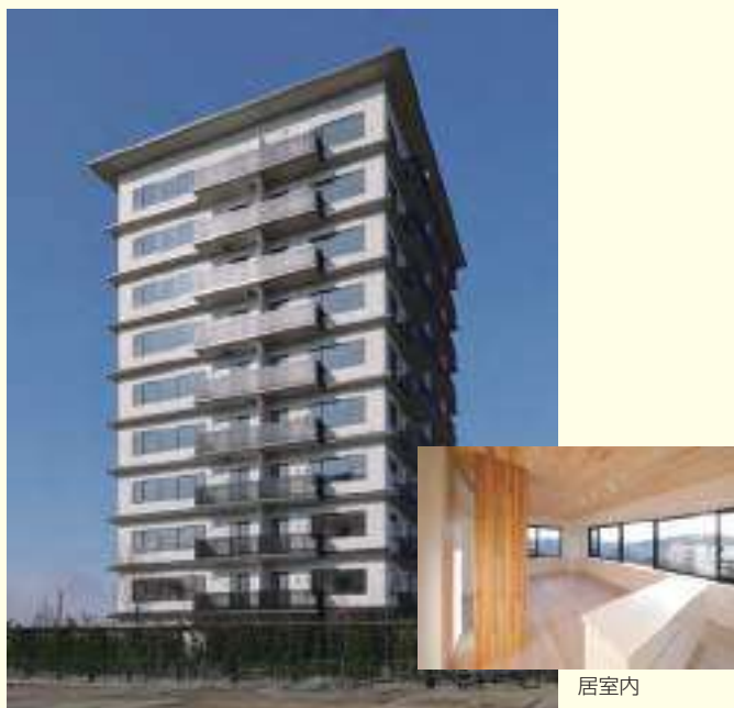
竣工した耐火構造(2時間)による 10階建てマンション
