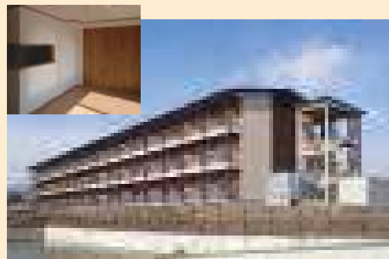
CLTを使用した復興公営住宅(福島県福島市)
