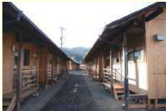
移築された木造応急仮設住宅
