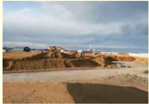
生育基盤盛土の造成風景
