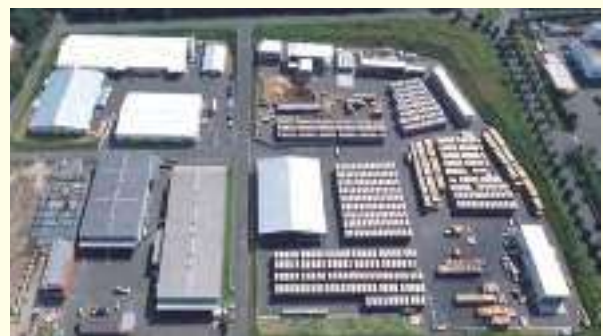
ツーバイフォー工法部材生産工場(鹿児島県霧島市)
