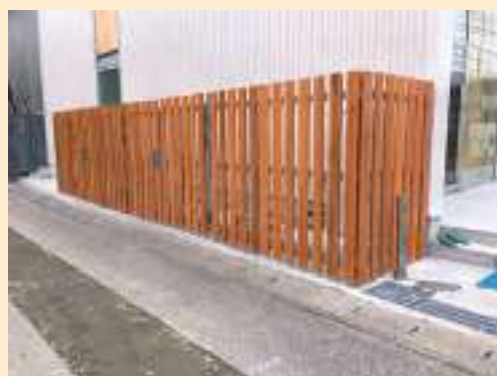
四国森林管理局嶺北森林管理署外壁フェンス (提供：国立研究開発法人森林研究・整備機構森林総合研究所)
