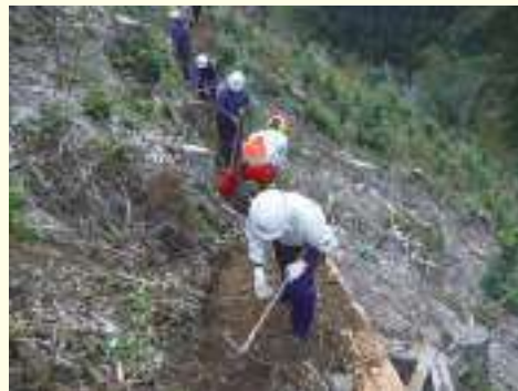
植付け現地実習の様子
