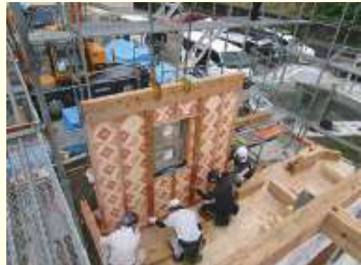
大型木造パネル住宅の施工の様子
