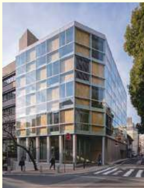
供用を開始した5階建てCLT・ 鉄骨ハイブリッドビル
