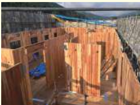
2階部分の建て方の様子
