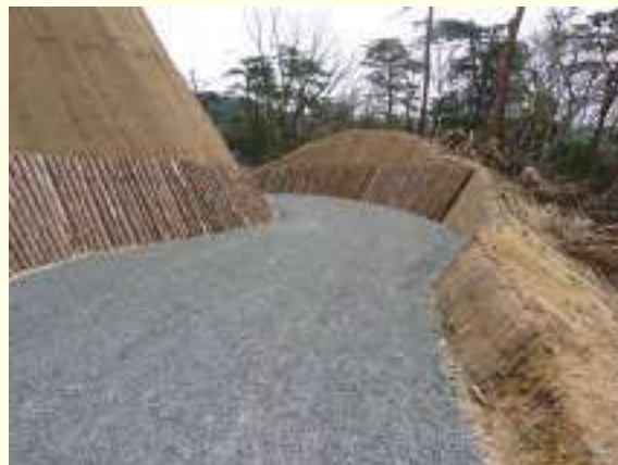
工事の支障木を利用した丸太伏工の林道
