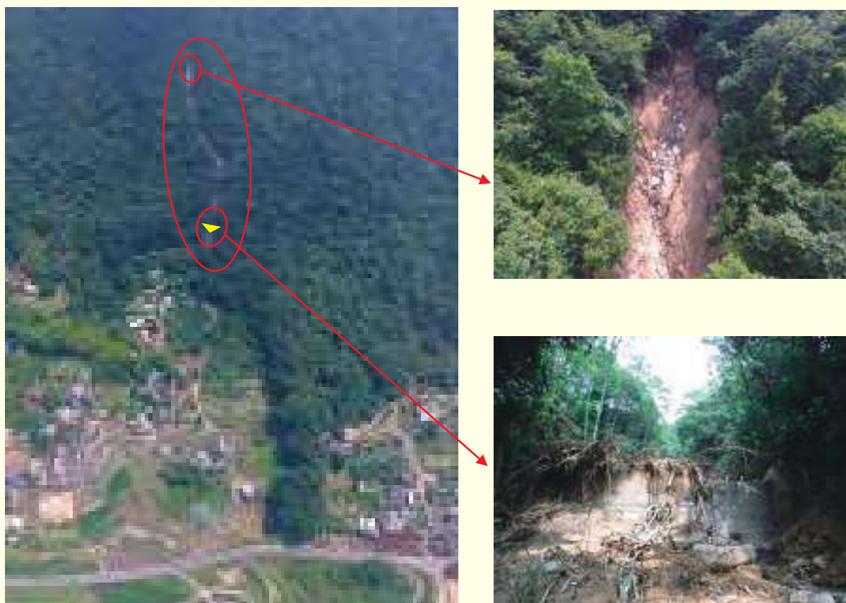
治山ダム(昭和42年度施工)による流木の流出等の抑制効果(岡山県笠岡市吉田地区)
