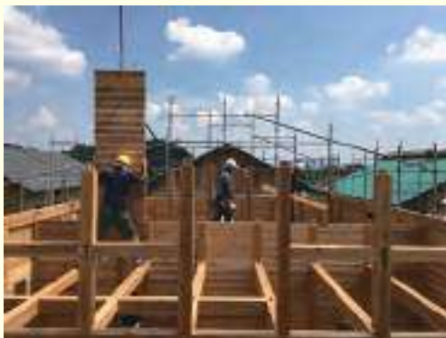
移築作業の様子
