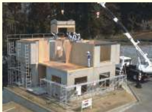
建設中の木質プレハブ住宅
