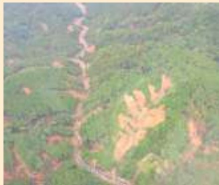
山腹崩壊の状況 (福岡県朝倉市奈良ヶ谷川上流)
