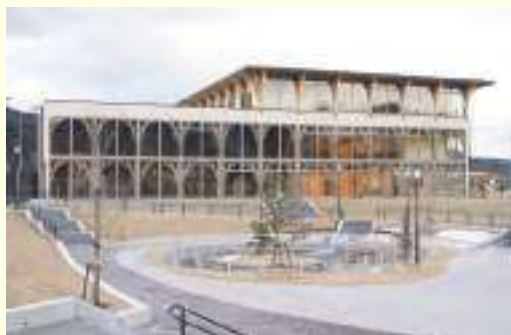
正面側の連続門型アーチ架構
