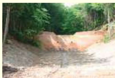
完成した治山ダム
