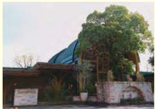
大断面集成材を用いたホテル施設 （鹿児島県鹿児島市、平成3（1991）年完成）
