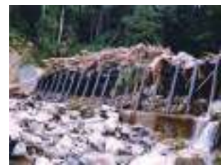
流木捕捉式治山ダムの設置
