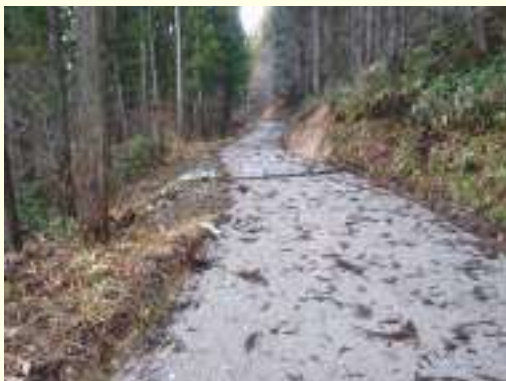
民有林に接続する作業道を開設
