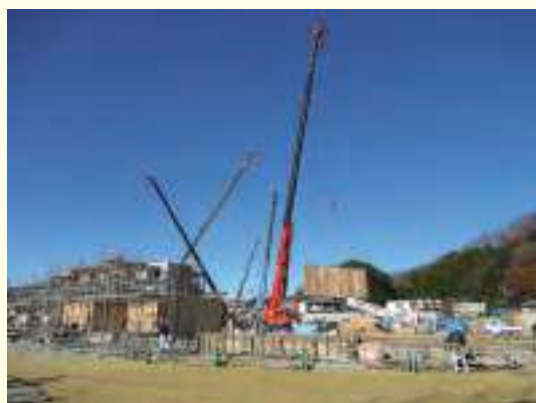
クレーンによるCLT壁パネルの据付け
