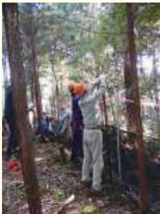
シカ食害防止ネット設置作業の様子
