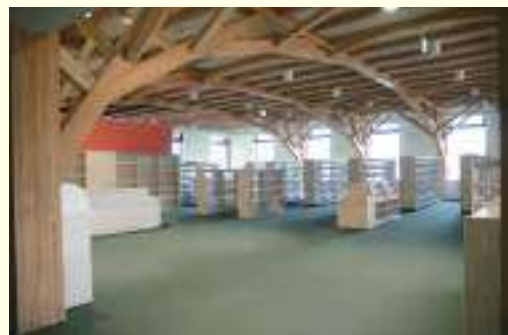
図書館の樹状方杖架構
