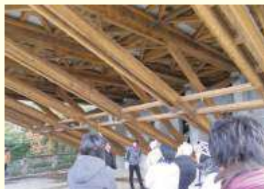
同社のスギ平角製材が使用された京都市東山区の寺院「青蓮院」の木造大舞台の構造部
