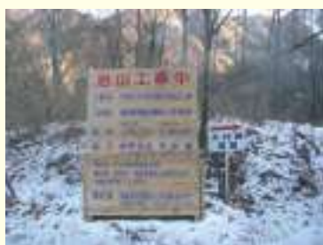
木製の工事看板
