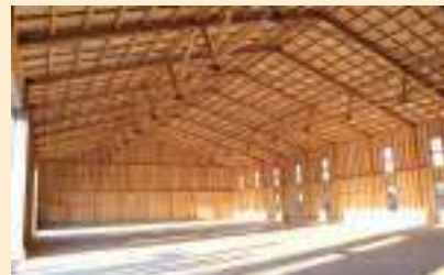
熊本県熊本市 肥後木材(株) 倉庫
