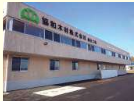
外装に1時間準耐火の外壁用木製集成材(WOOD.ALC)を使用した管理棟
