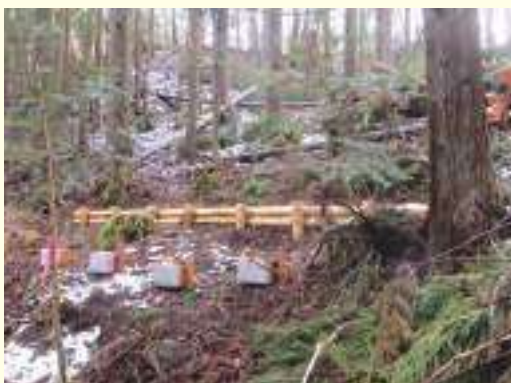
土砂受け箱設置(表土流出防止対策検証) (富岡町・大熊町)
