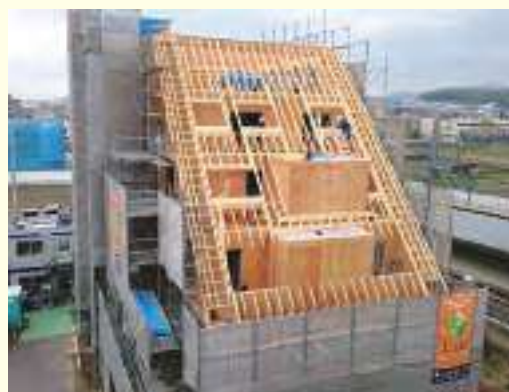
施工中の様子
