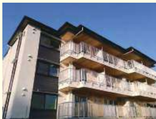
CLTパネル工法により建設された復興公営住宅
