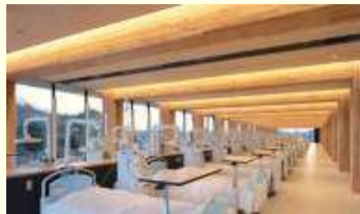
門型木フレームが連続する透析室の内観
