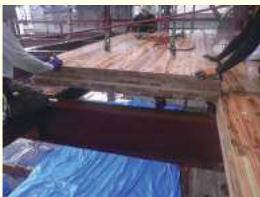
事務所棟のCLT床の施工の様子
