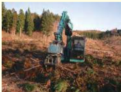
伐採と造林の一貫作業システム事業地での地拵えの様子
