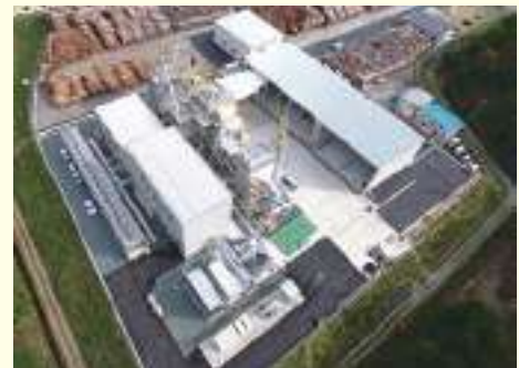
朝来市の工業団地内に整備された施設
