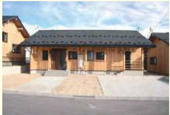
応急仮設住宅の部材を利用して建設された災害公営住宅
