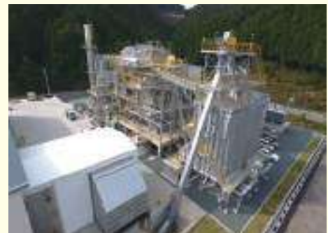
木質バイオマス発電所
