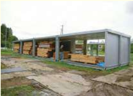
解体した応急仮設住宅の部材を一時保管
