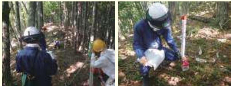
境界標の復元作業の様子
