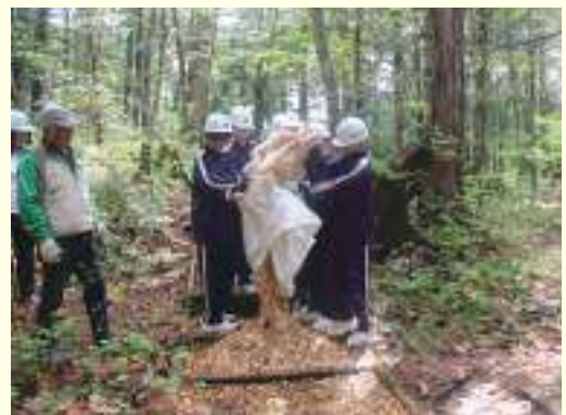
遊歩道におけるヒノキチップ敷設作業
