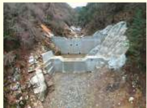
梨子沢に新たに設置された治山ダム
