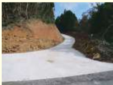
民有林施工の林業専用道
