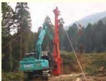
開発されたタワーヤーダ
