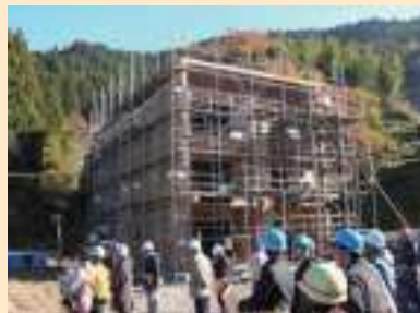
実証的CLT建築の現場における構造見学会
