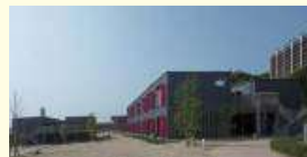
「CLTパネル工法」による宿泊施設
