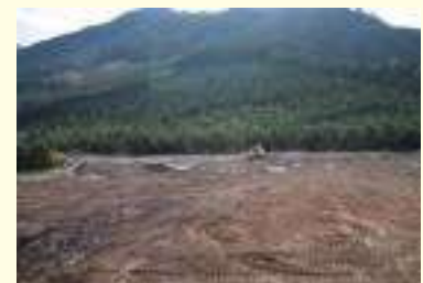
コンテナ苗生産施設整備予定地の敷地造成 (岐阜県下呂林木育種事業地)
