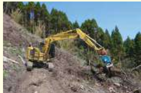
グラップルによる皆伐後の片付け作業
