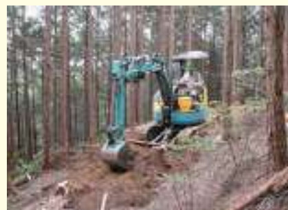
研修生による作業道開設の様子
