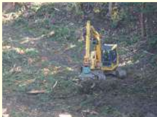
伐採と同時期に実施する地捨えの様子
