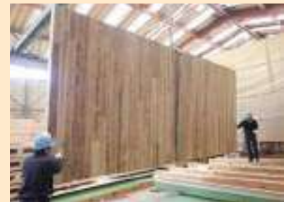
工場でのCLT生産
