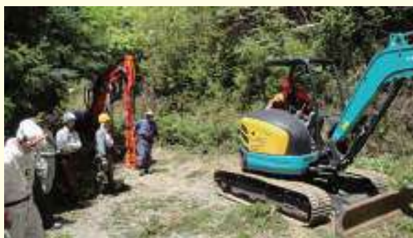
岐阜県における路網整備講習会の様子
