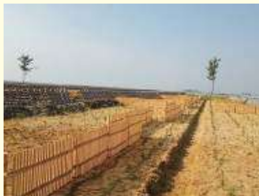
国有林材を使用して作設された防風柵と防風垣
