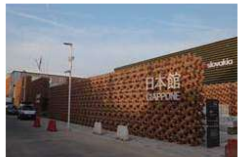
国産カラマツ集成材を活用した 日本館の外壁
