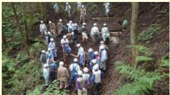
地域住民による木柵工の施工
