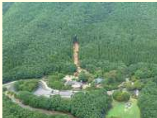
被害箇所の様子
