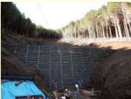
谷止工の施工状況(静岡県小山町)
