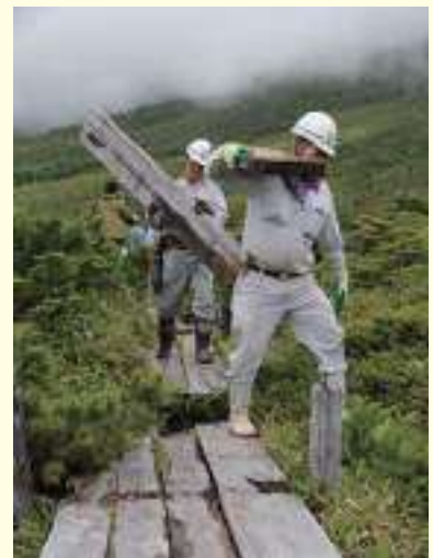
老朽化した木道の撤去の様子
