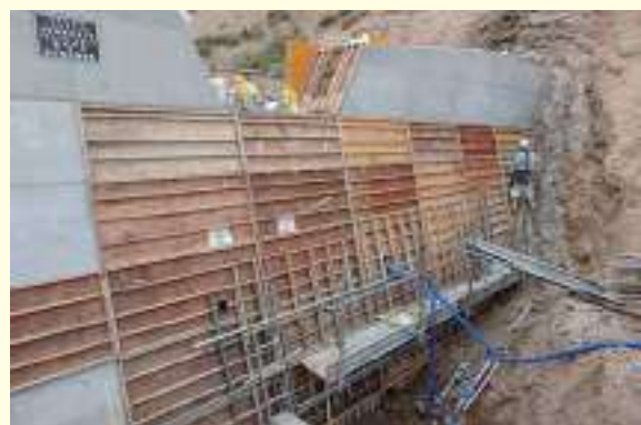
設置された国産材型枠用合板
