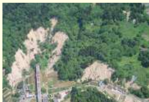
被災状況(新潟県小千谷市)
