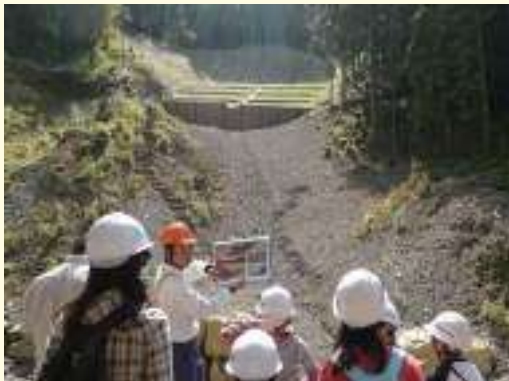
治山事業施工地での現地説明
