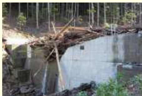
治山ダムによる流木の流出等の抑制効果の事例 (兵庫県丹波市)
