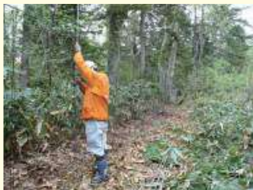
シカ侵入防護柵設置状況
