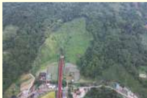
復旧状況(新潟県小千谷市)
