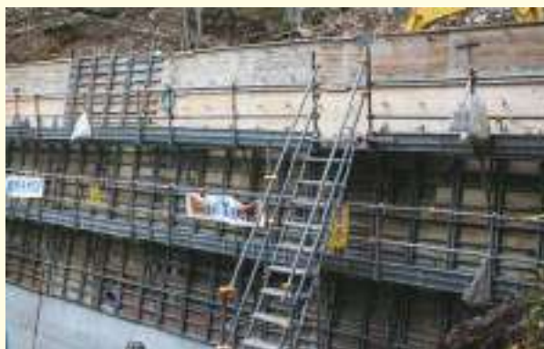
国産材型枠用合板の設置状況
