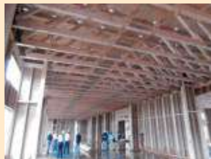
工場棟(福井県福井市)
