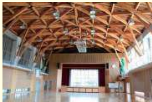
屋内運動場の内部
