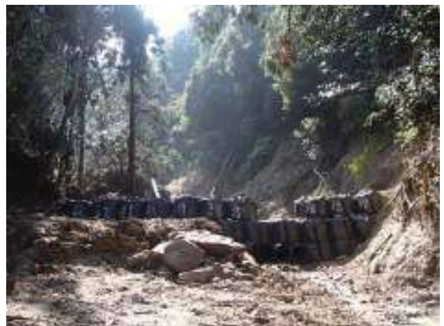
大型土嚢の設置による応急対策
