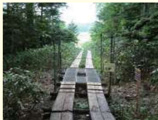
グレーチングの設置状況
