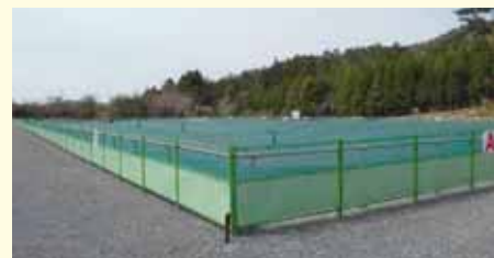
除去土壌等の仮置場の様子
