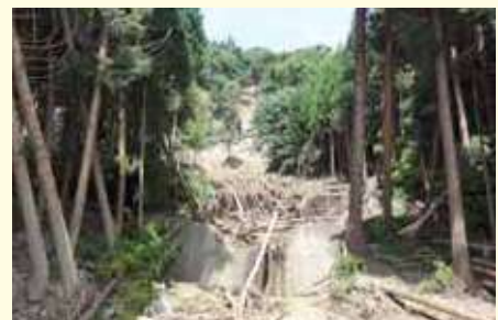
治山施設による溪床や山脚の固定効果
