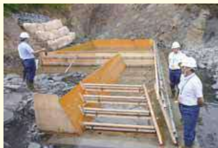
国産材型枠用合板の使用現場
