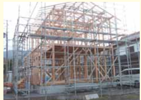
木造の復興住宅の建設
