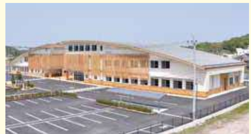
木造3階建て市庁舎の全景
