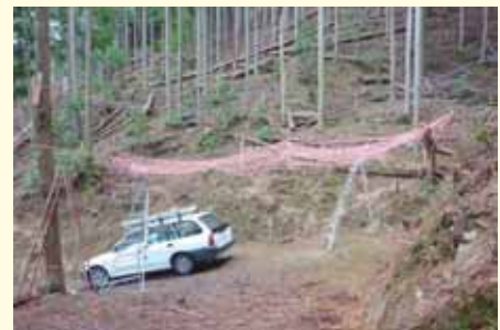
作業道上に設置した森林用ドロップネット
