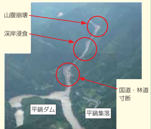
被災状況(高知県北川村奈半利川)
