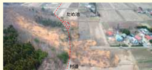
山腹崩壊の状況
