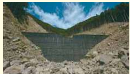
平成25(2013)年に完成した谷止工
