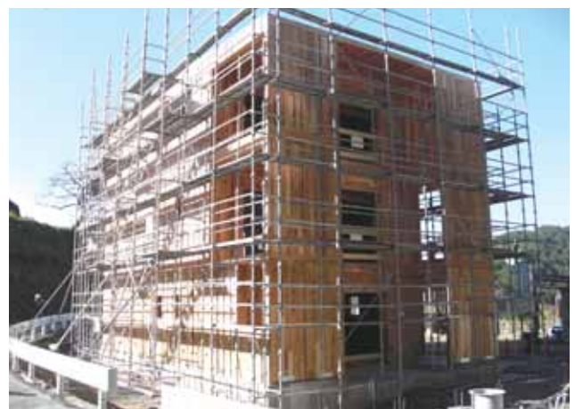
CLT で建築中の3階建て社員寮（高知県長岡郡）
