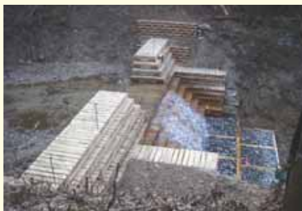
施工した木製治山ダム
