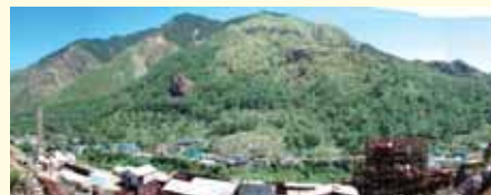
現在の足尾治山事業地
