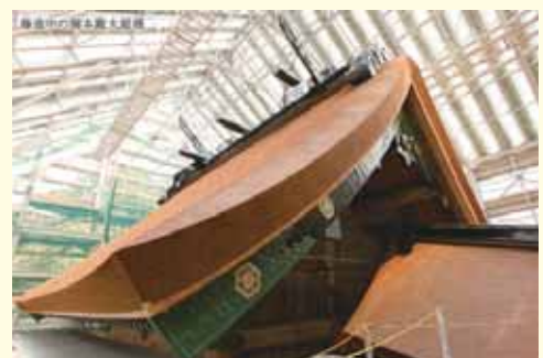
檜皮が葺かれた御本殿大屋根
