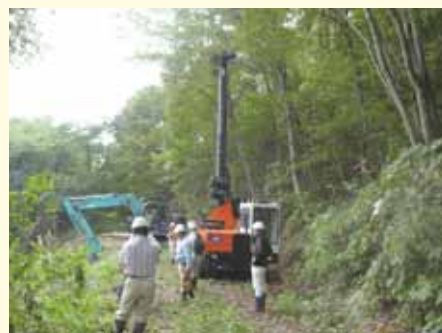
タワーヤーダを設置している様子
