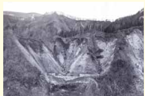
赤城山系での被害状況(山腹工事施工前)
