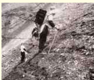
足尾治山事業地で植生盤筋工に取り組む様子
