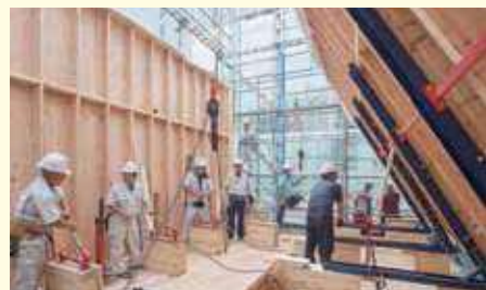
現場でジャッキを使い耐火外壁を建て起こす様子
