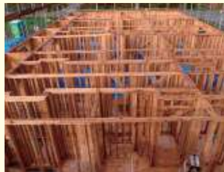
「気仙杉」を用いた集合住宅の建設
