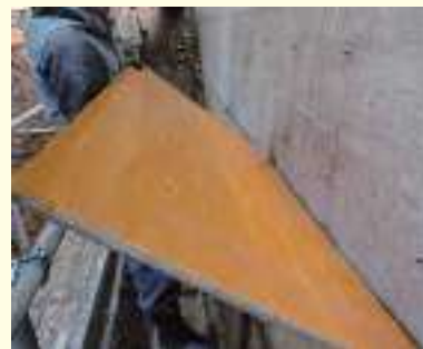
国産材針葉樹の型枠用合板を用いてコンクリートを打設した施工現場
