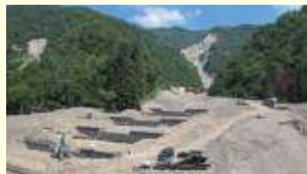
復旧工事の様子
