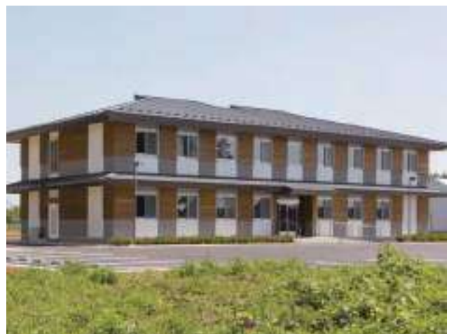
木造で整備された公共建築物 (横浜植物防疫所つくばほ場)
