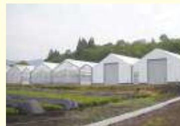
コンテナ苗生産施設の外観
