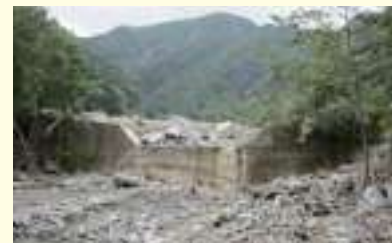
治山堰堤における溪床の固定効果 (熊本県阿蘇市)
