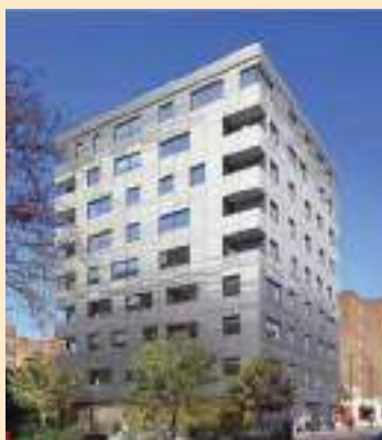
英国ロンドンで、CLTを用いて建築された集合住宅(木造9階建て。ただし1階部分は鉄筋コンクリート造)
