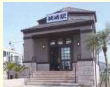
枕崎駅舎の外観
