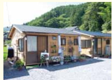
岩手県住田町 すみたちょう による木造仮設住宅
