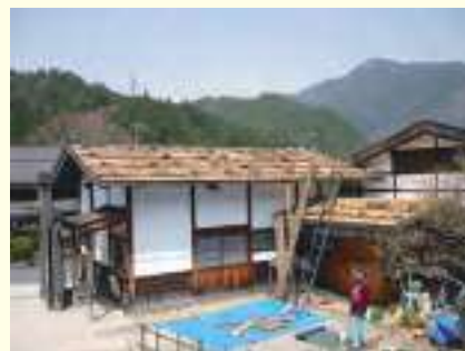
板葺き石置き屋根の葺き替えの様子
