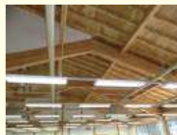
写真：カラマツ集成材等を使用した事務室
