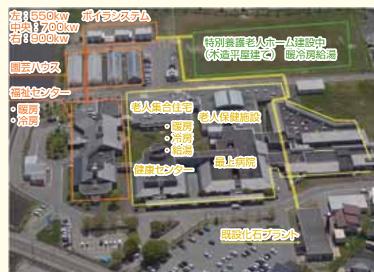
もがみウェルネスプラザの熱供給システム
