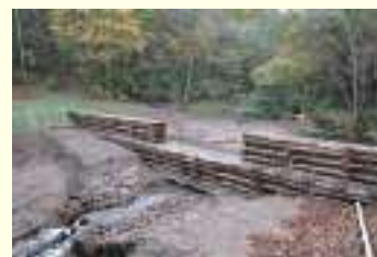
写真：間伐材を利用した木製床固工
