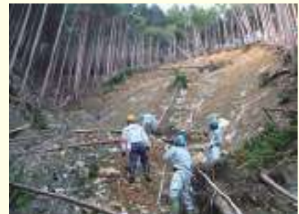
被災状況の調査
