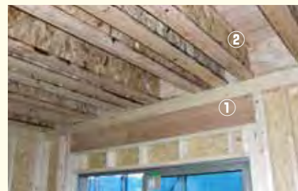
住宅に使用された山梨県産カラマツLVL①とI型ジョイスト②
