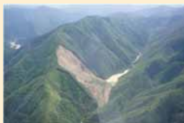
台風第12号による被害(奈良県十津川村長殿)
