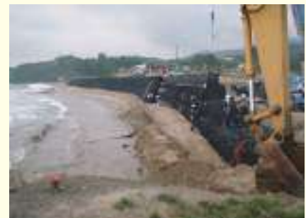
大型土のうによる緊急対策工事
