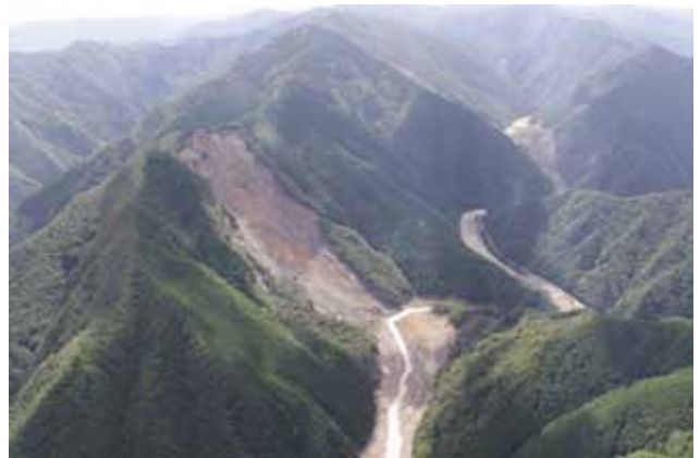
台風第12号に伴う豪雨による被害（奈良県五條市 ごじょうし ） 大規模な山腹崩壊により河道閉塞が発生。
