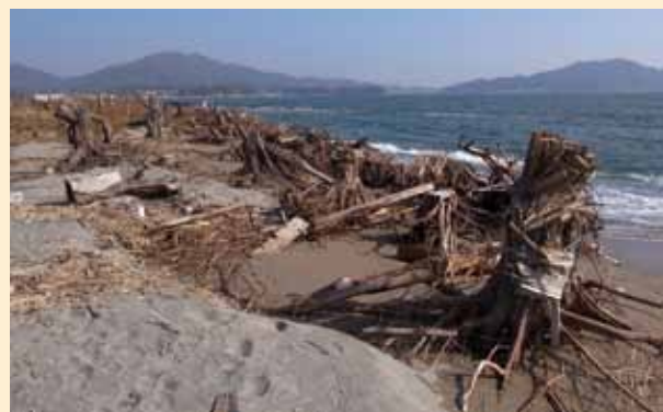
被災後の状況
