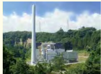
木質バイオマス発電所
