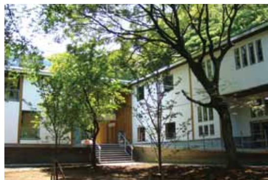
平成21(2009)年9月に、国立大学法人東京大学が建築した教職員の福利厚生・教育研究支援施設「向ヶ丘ファカルティハウス」。プレカット加工した一般流通材を用いて、在来工法により建築。
