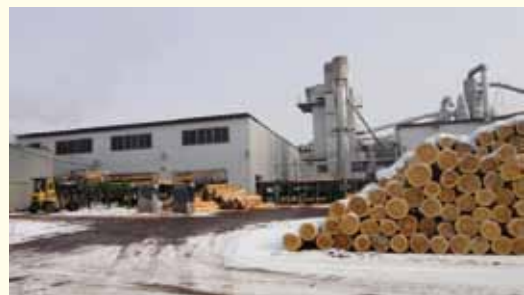
木質バイオマスボイラーを利用した製材工場
