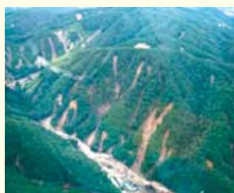
梅雨期の大雨による被災状況
