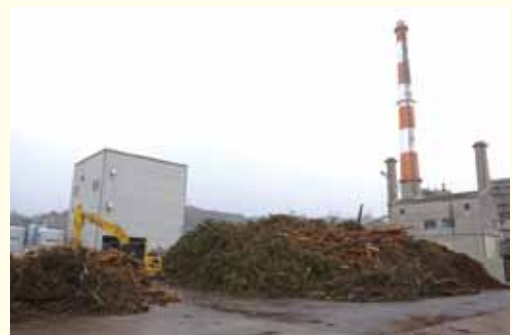
石炭火力発電所の未利用間伐材等受入れ施設
