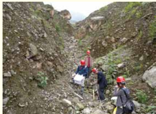
地震崩壊箇所での測量
