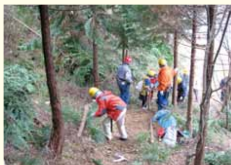
隊員による歩道修理
