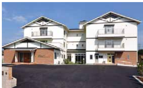
平成22(2010)年7月に、岡山県玉野市 たまのし で建築された特別養護老人ホーム。国内最大級の在来工法による木造耐火建築物で、地域材を多用。
