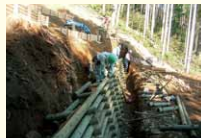
間伐材を利用した丸太積土留工
