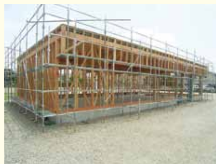
建設中のコンビニエンスストア
