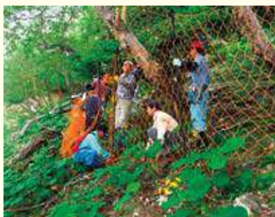
防鹿柵の設置
