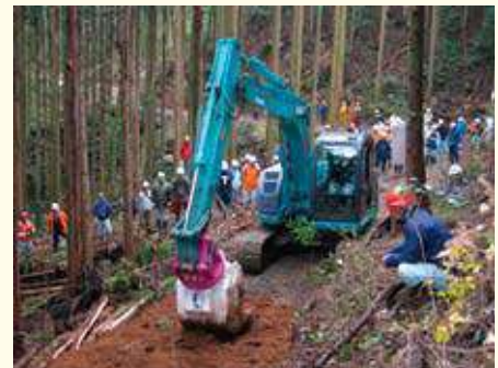
グラブ付バケットを用いた路網作設
