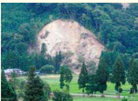
栗駒ダム下流の崩壊地(復旧前)
