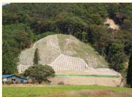
栗駒ダム下流の山腹工(復旧後)
