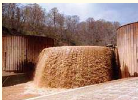
産女川上流に設置した鋼製治山えん堤
