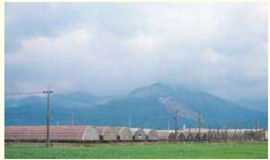
木質バイオマス利用ボイラーを導入した養鰻場
