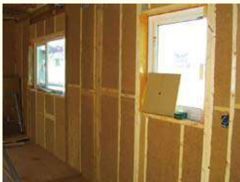
写真左:断熱材 写真下:柱間に断熱材を 施工した様子
