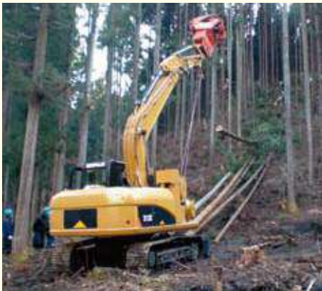
アームをタワーとして使用し、主索を用いない簡易な架線による集材機
