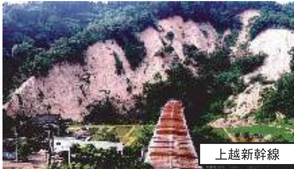
上越新幹線妙見トンネル付近の被害状況 (平成17年6月)
