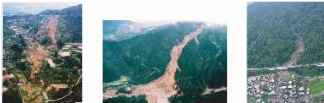
左：平成16年新潟県中越地震による災害（新潟県長岡市（旧山古志村）） 中：平成17年台風第14号による災害（宮崎県宮崎市（旧田野町）） 右：平成18年7月豪雨による災害（長野県岡谷市）
