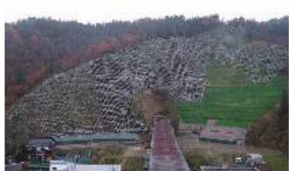
復旧状況 (平成18年11月)
