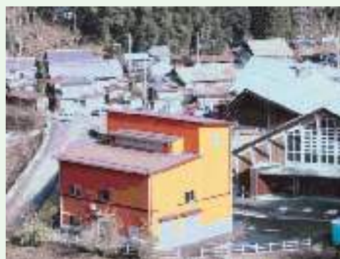
発電施設（中央オレンジ色の施設）
