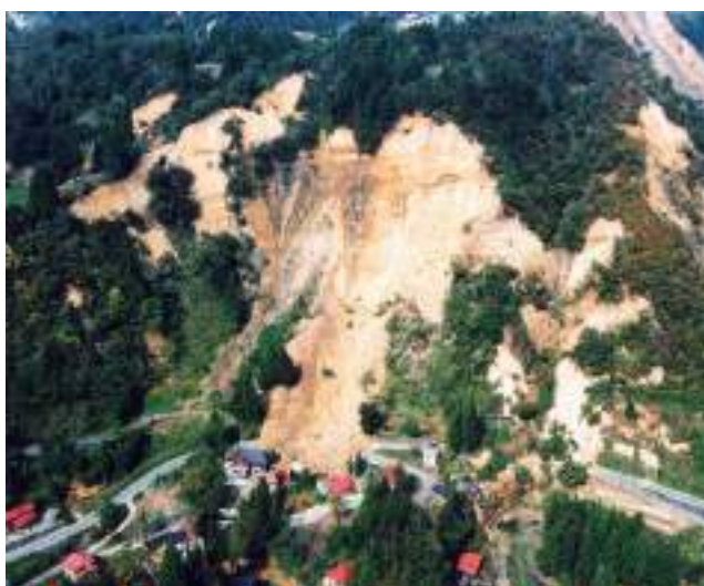
多発する山地災害（平成16年10月23日新潟県山古志村）
