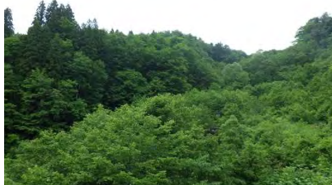
木地屋川 復旧状況 (R5)
