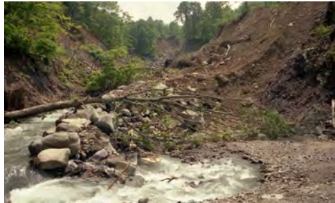
木地屋川 荒廃状況
