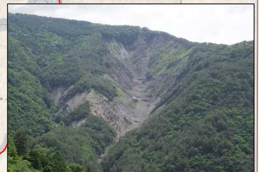
⑤ 小渋川区域(鳶ヶ巣)復旧状況
