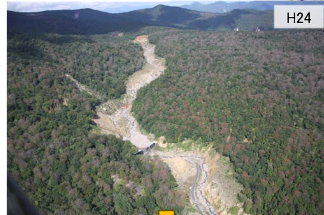
【①ドゾウ沢 復旧状況】
