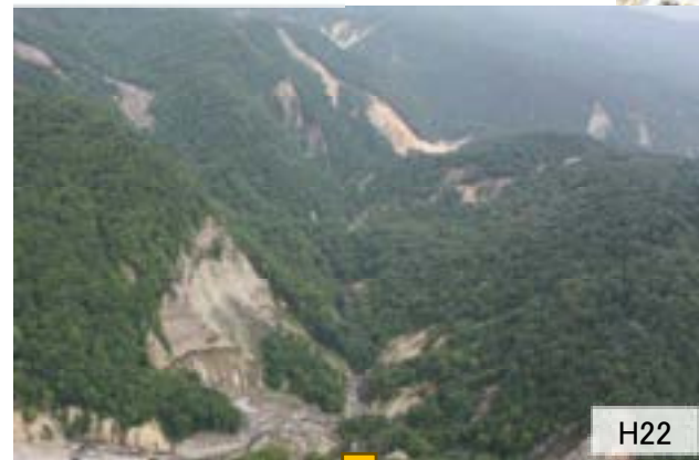
【①湯ノ倉 復旧状況】
